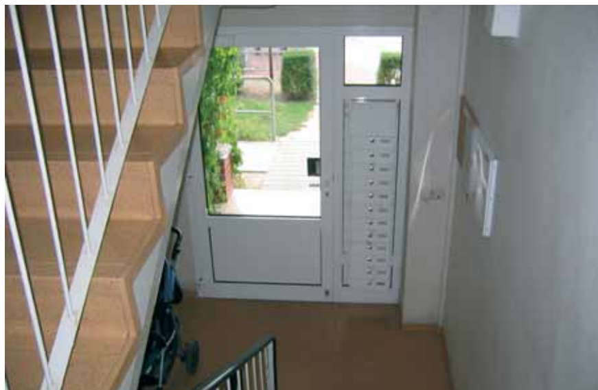
Transparenter Eingangsbereich bei der Warener Wohnungsgenossenschaft
